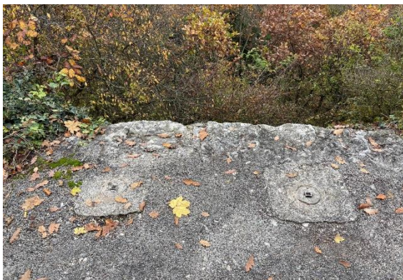
Mise en place d'une barrière de sécurité
